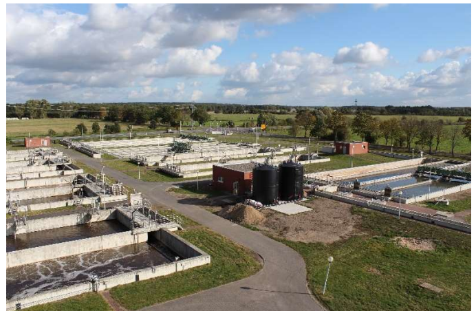
Die KA Stendal ist auf 115t EGW ausgelegt und aktuell voll ausgelastet. Sie wird von einem 116 km langen Kanalnetz mit 30 Pumpwerken gespeist.
