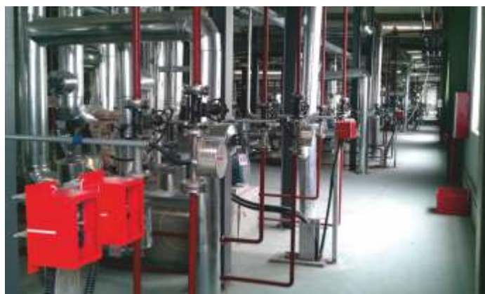
Pumpen der Baureihe CNH-B 50-315; Fördermedium EG (Äthylen Glykol)
