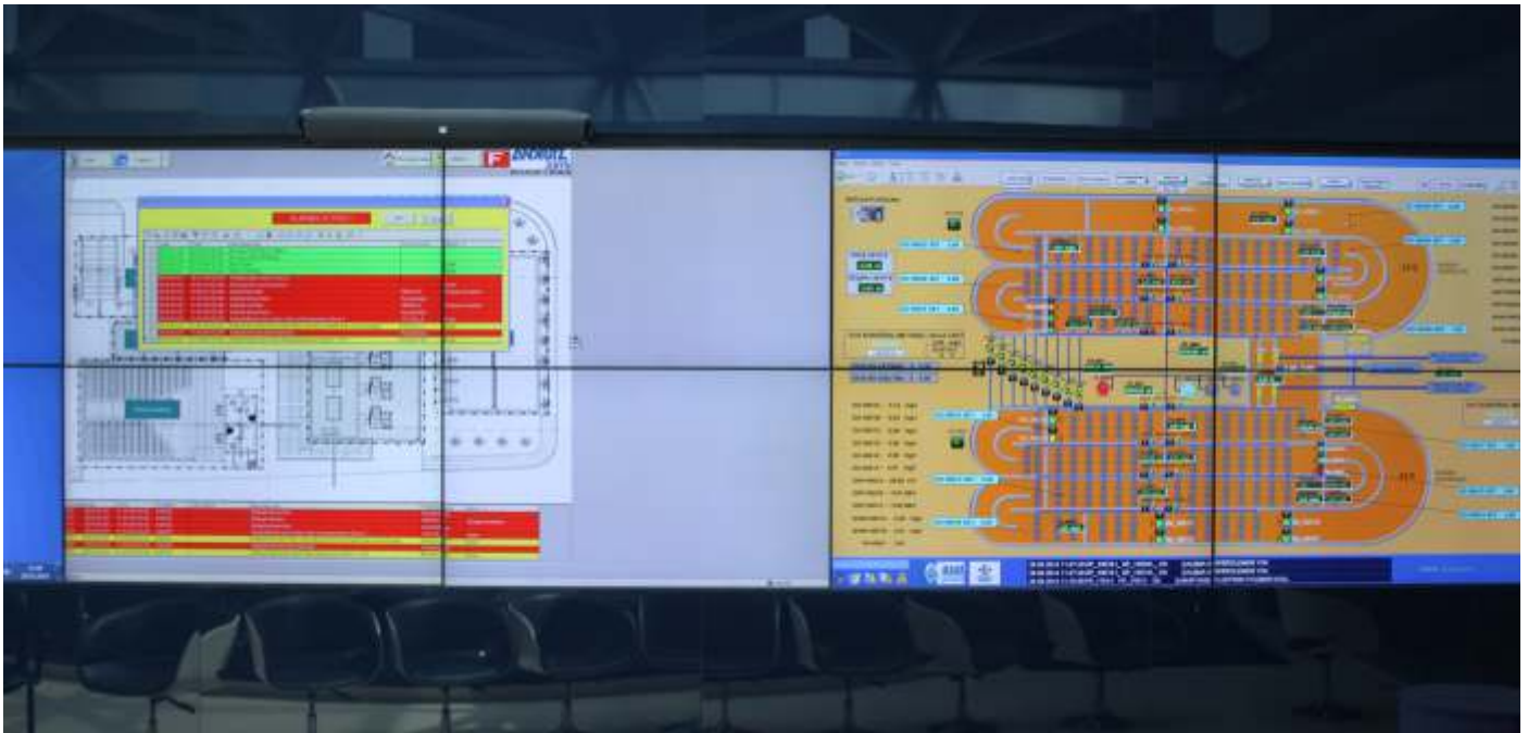
Die Technologie der Anlage ist in der Türkei einzigartig und wird in einem modernen Schulungsraum auf einer Videowand dargestellt.
