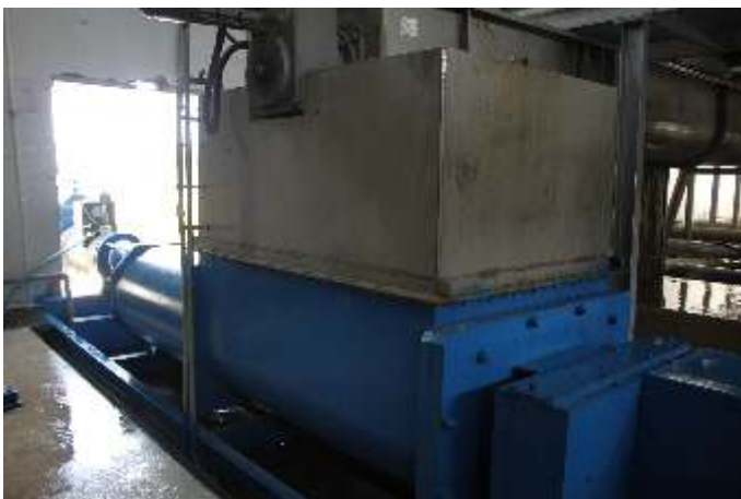
Anwendung: Schlammförderung zur Trocknung Pumpenserie: Allweiler® AE 1+1N 5000-RG Hochdruck-Exzentrerschneckenpumpe Distanz: 70 m (230 feet)
