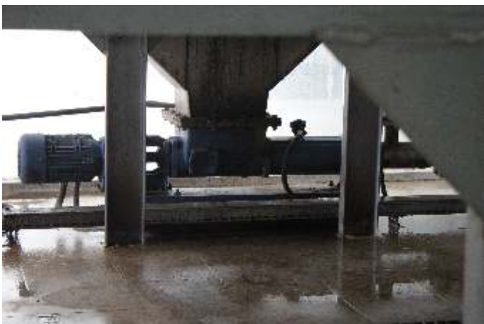
Anwendung: Schlammförderung Pumpenserie: AEB 1L 551 Druck: 1 bar (14,5 psi) Fördermenge: 15 m 3 /h (66,1 gpm)
