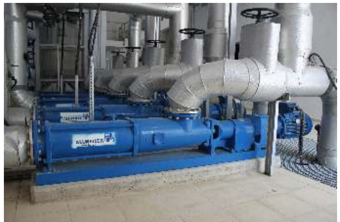
Anwendung: Schlammförderung Pumpenserie: AE 1E 5000 Druck: 2,7 bar (39,2 psi) Fördermenge: 161 m 3 /h (709 gpm)
