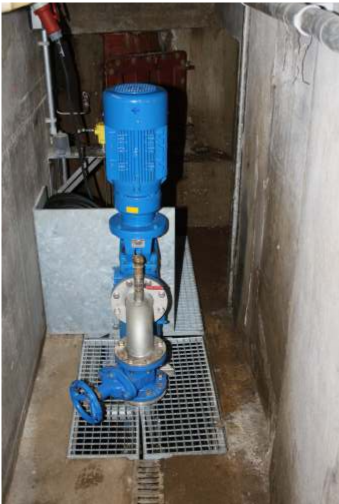
Allweiler-Exzentrerschneckenpumpe
