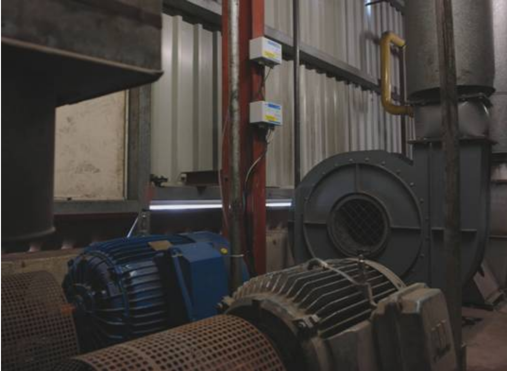
Typischer Aufbau einer Thermalölpumpe mit ALLMIND"
