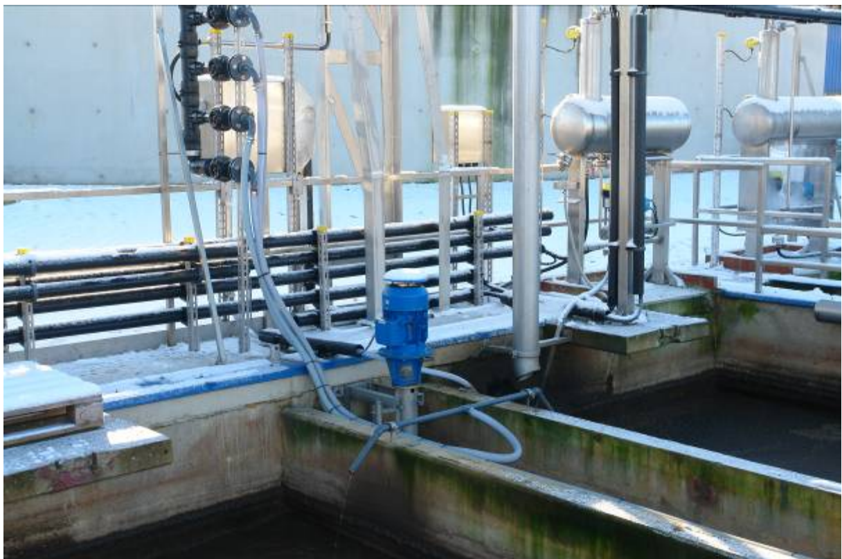
Allweiler-Propellerpumpe (Baureihe „PT 300“) zur Umwälzung (400 m 3 /h mit 1,1 kW Leistungsbedarf)
