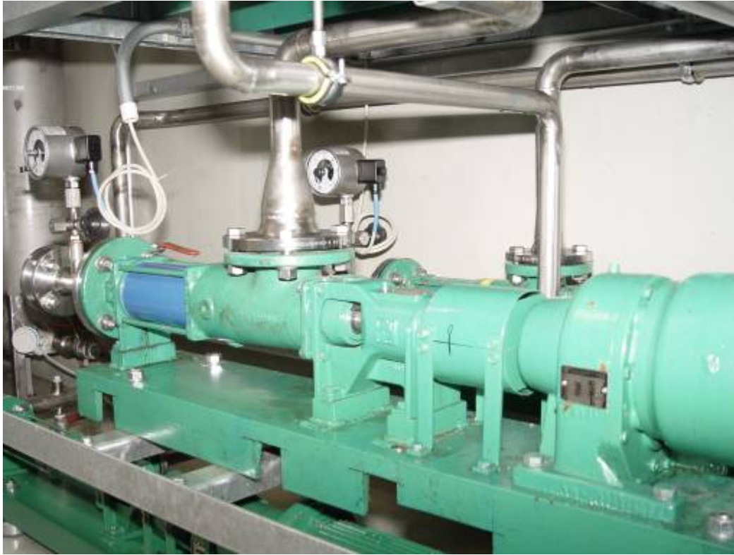
ALLWEILER Exzentrerschneckenpumpe zur Förderung von Glycerinphase, Förderdruck 2 bar, Fördermenge 6 m 3 /h.
