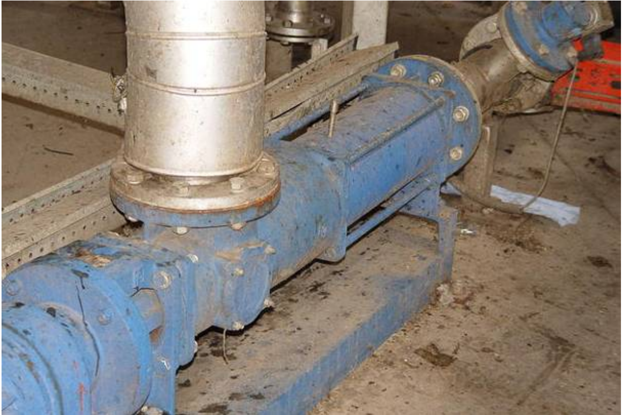
Allweiler Exzentrerschneckenpumpe der Baureihe AEB1E750, Medium: Biomasse mit 75 °C, Fördermenge: 18 m 3 /h, Druck: 2 bis 4 bar
