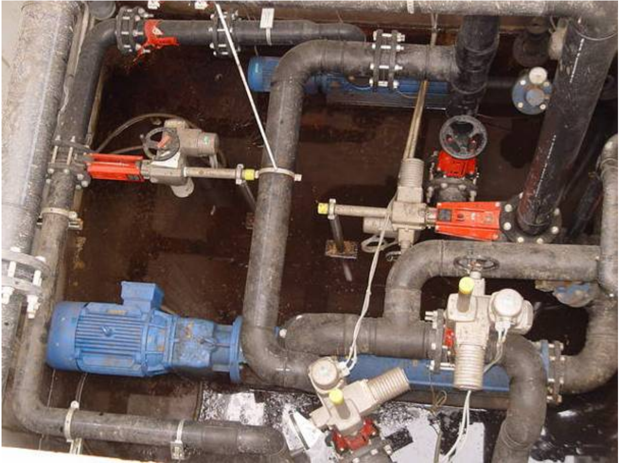
Allweiler Exzentrerschneckenpumpe der Baureihe AEB1E1450, Medium: Gärreste, Fördermenge: 60 m 3 /h, Druck: 4 bis 5 bar
