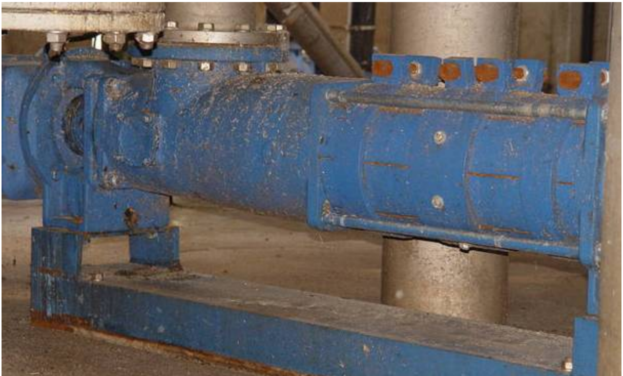
Allweiler Exzentrerschneckenpumpe der Baureihe AEB1E2700 mit nachspannbarem Stator, Medium: Biomasse, Fördermenge: 100 m 3 /h, Druck: 2 bar
