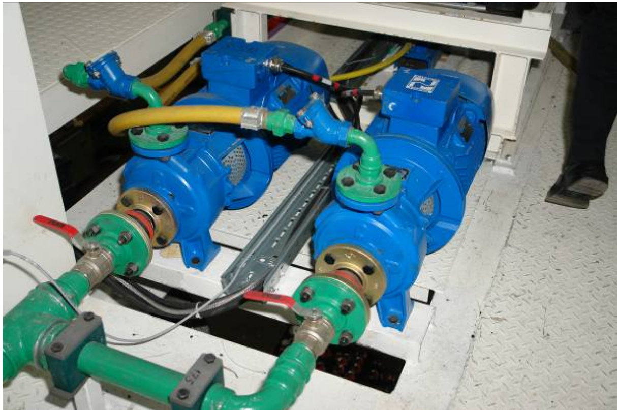
Allweiler-Kreiselpumpen der Baureihe „NB“ als Wasser-Pumpe.
