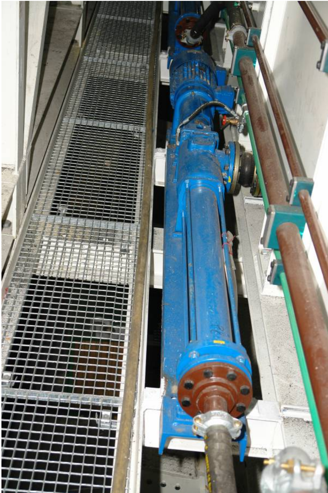
Allweiler-Exzentrerschneckenpumpe der Baureihe „AE-H“ als Bentonit-Pumpe.
