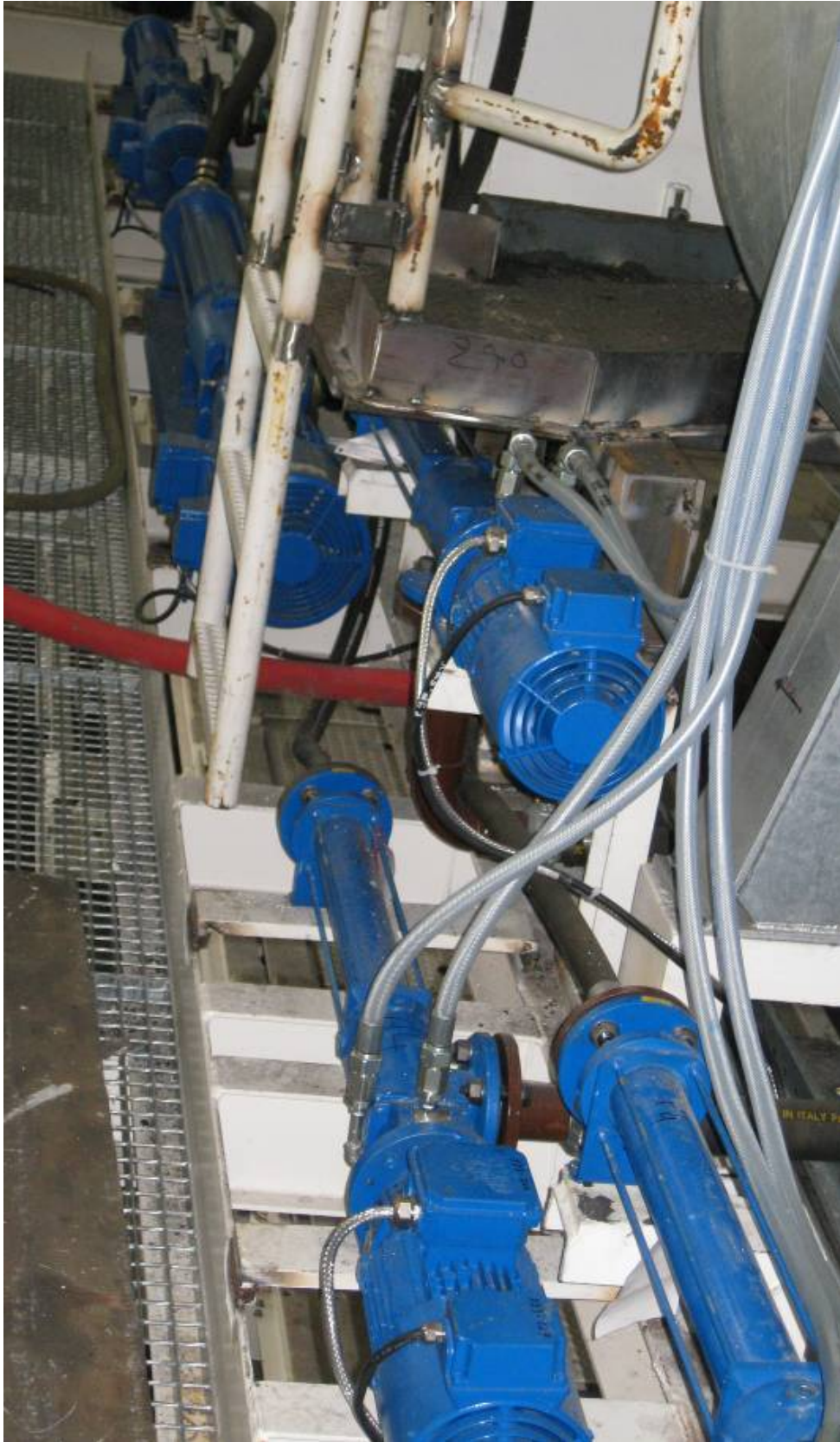
Allweiler-Exzentrerschneckenpumpen der Baureihe „AEB-H“ als Dosier-Pumpe mit Quench.
