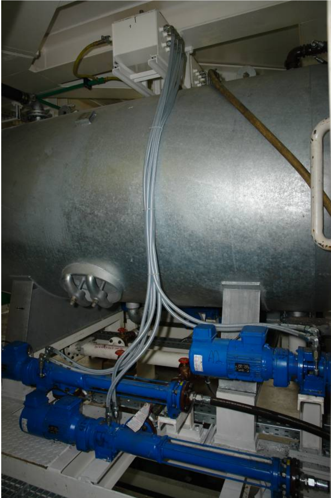
Allweiler-Exzentrerschneckenpumpen der Baureihe „AEB-H“ als Dosier-Pumpen mit Quensch für Beschleuniger.
