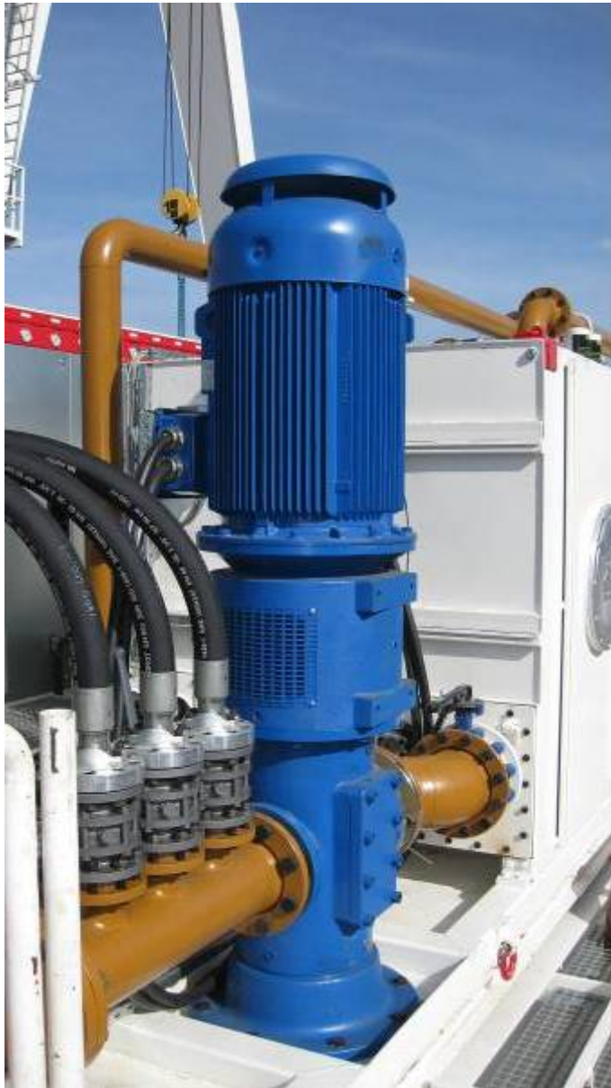
Allweiler-Schraubenspindelpumpe der Baureihe „SN“ als Filterölpumpe und für den Einsatz im Kühlsystem.
