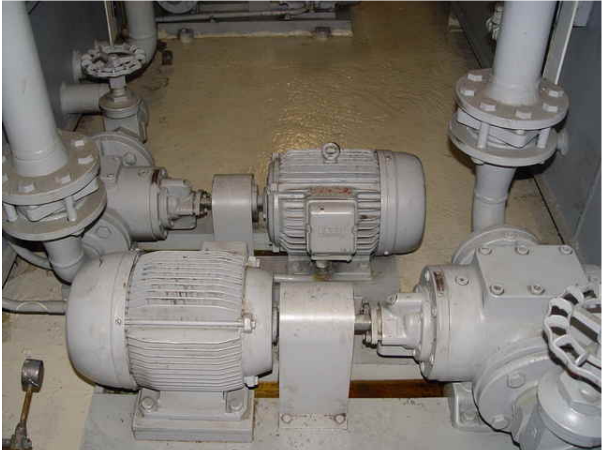
Zwei von etwa 40 Schraubenspindelpumpen der Baureihe "SNH", die seit etwa 30 Jahren im Tanklager ohne Ausfall oder Revision Grundöle fördern.
