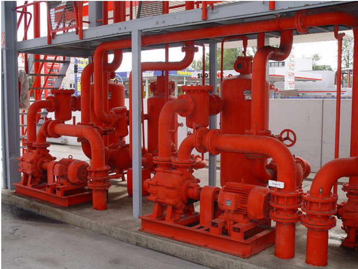
Abfüllanlage für Spezialbenzin. Fördermenge ca. 200 m 3 /h über eine Förderhöhe von ca. 100 m.
