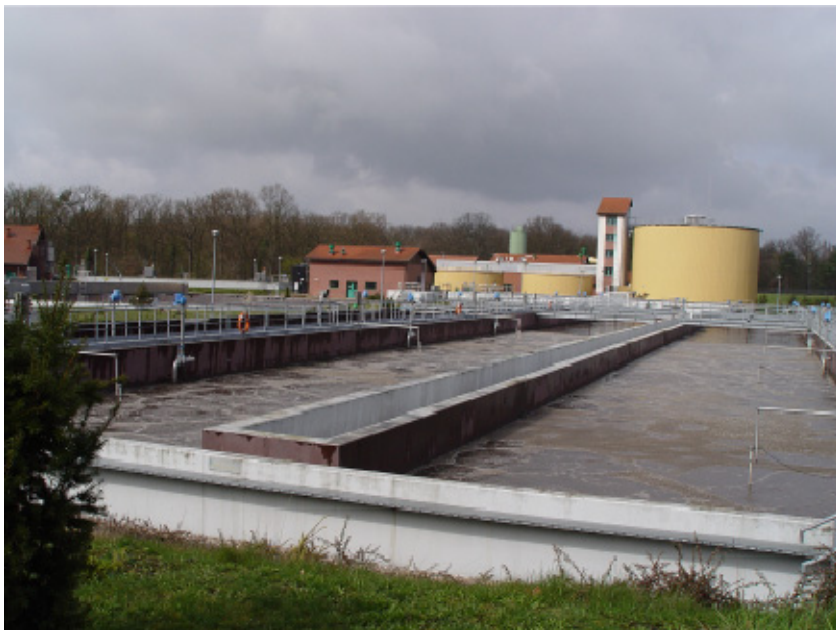
Deutsch-polnische Gemeinschaftskläranlage Guben-Gubin.
