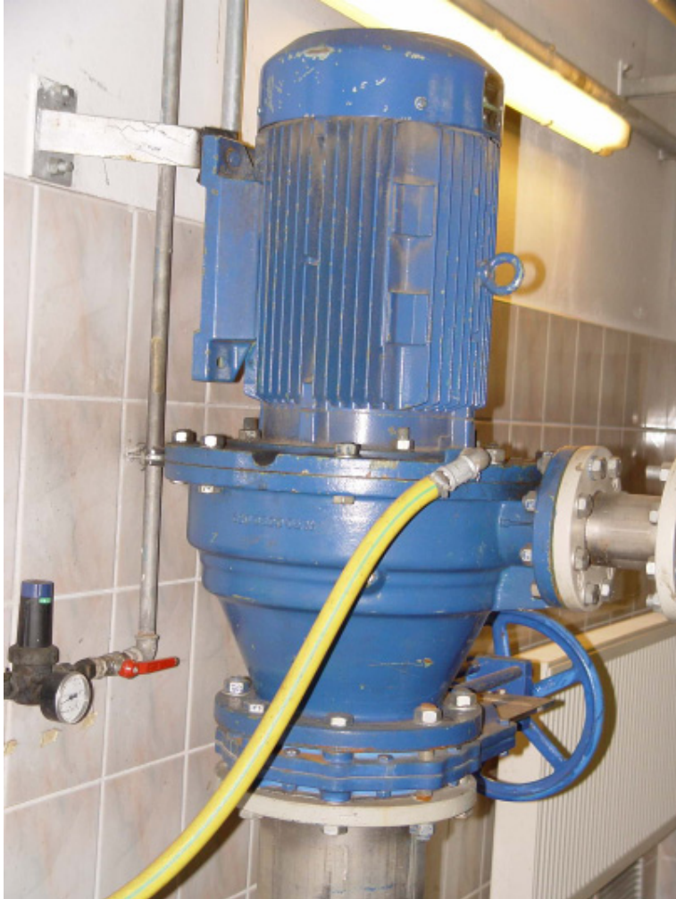
Mazerator zur Beschickung des Faulturms, Baureihe ABM80-S. Fördermenge bis zu 160 \text{ m}^3/\text{h} .
