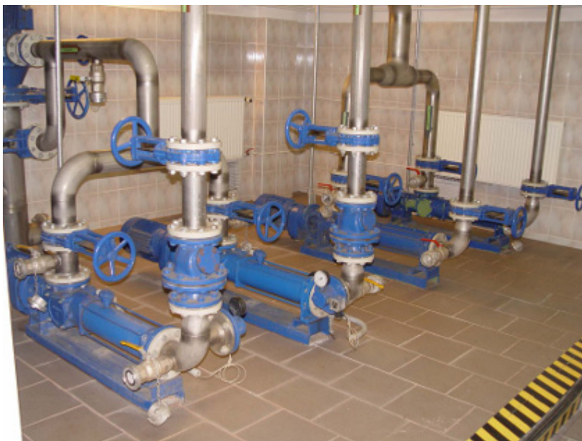
Mazerator zur Beschickung des Faulturms, Baureihe ABM80-S. Fördermenge bis zu 160 \text{ m}^3/\text{h} .
