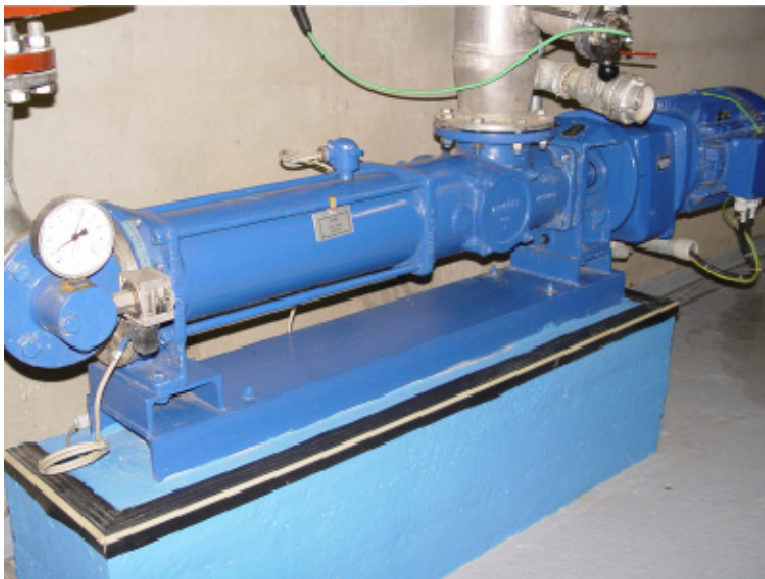
Pumpe SEBP 1000 zur Förderung von Primärschlamm zum Voreindicker, Fördermenge 170 bis 700 l/min.
