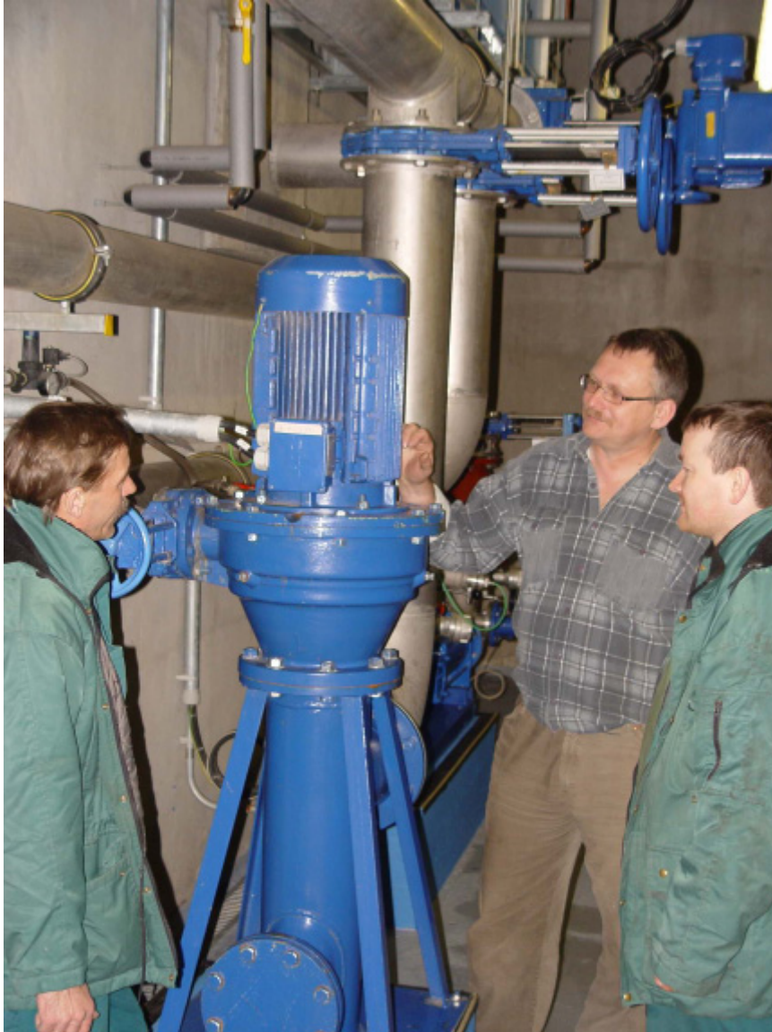
Mazerator vom Typ ABM 80-S in der Zufuhr des Primärschlammes zum Voreindicker.
