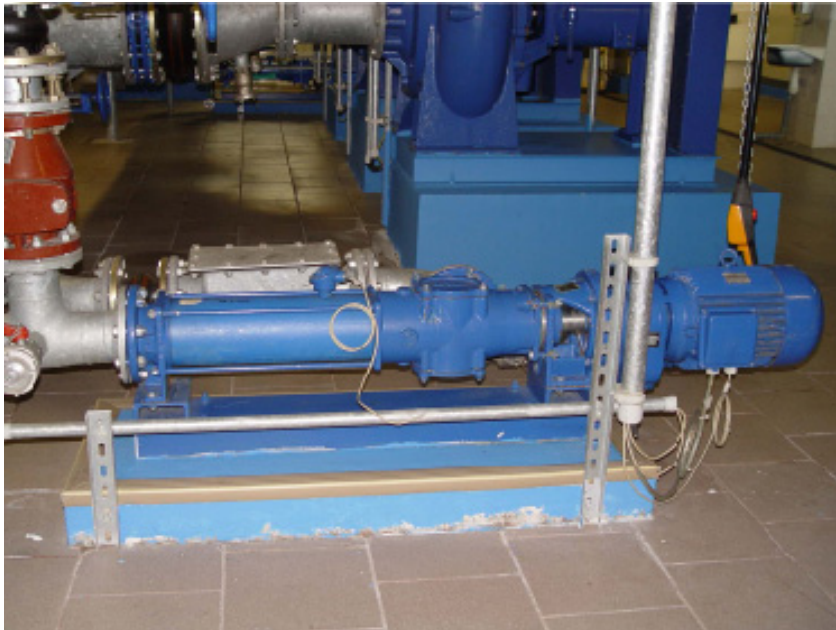
Exzentrerschneckenpumpe SEBP 550 zur Förderung des Überschussschlammes zur mechanischen Eindickung; Fördermenge 130 bis 260 l/min.
