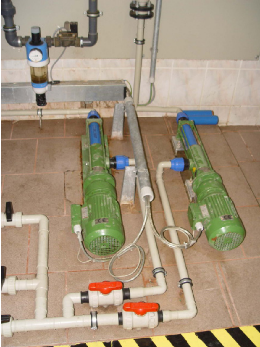
Allweiler Exzentrerschneckenpumpen der Baureihe ANBP als Flockungsmittelpumpe in der Entwässerung (max. 10 l/min bei 12 bar und max. 20.000 mm 2 /s).
