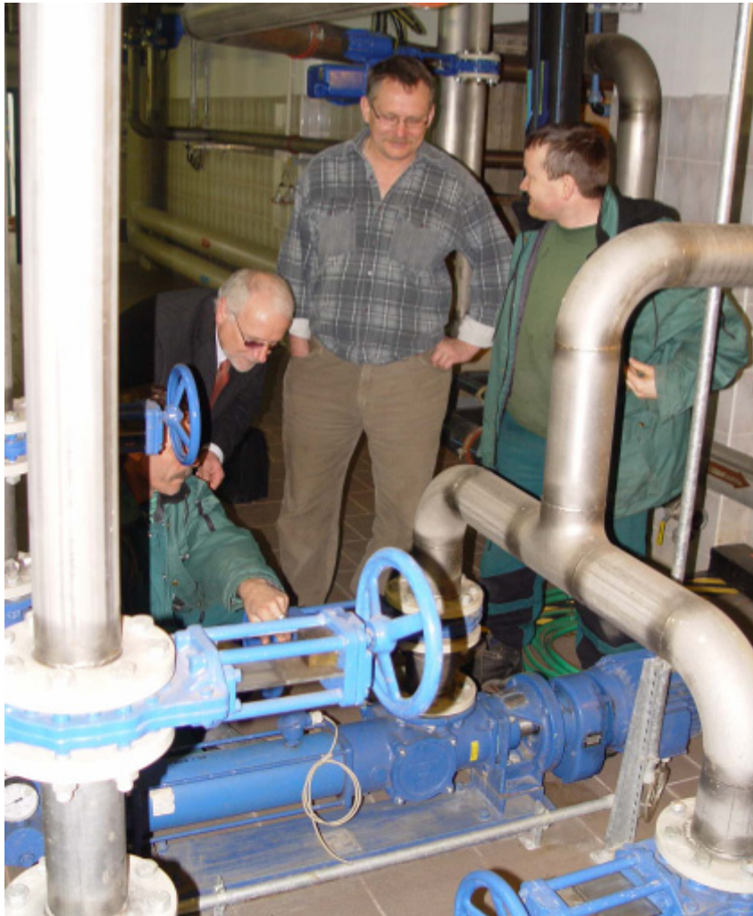
Exzentrerschneckenpumpen der Baureihe SEDBP 200 zur Förderung von Frischschlamm zum Faulturm und zu den Zentrifugen. Fördermenge 170 l/min (max. 800 l/min, max. Druck 12 bar, max. Viskosität bis 150.000 mm 2 /s).
