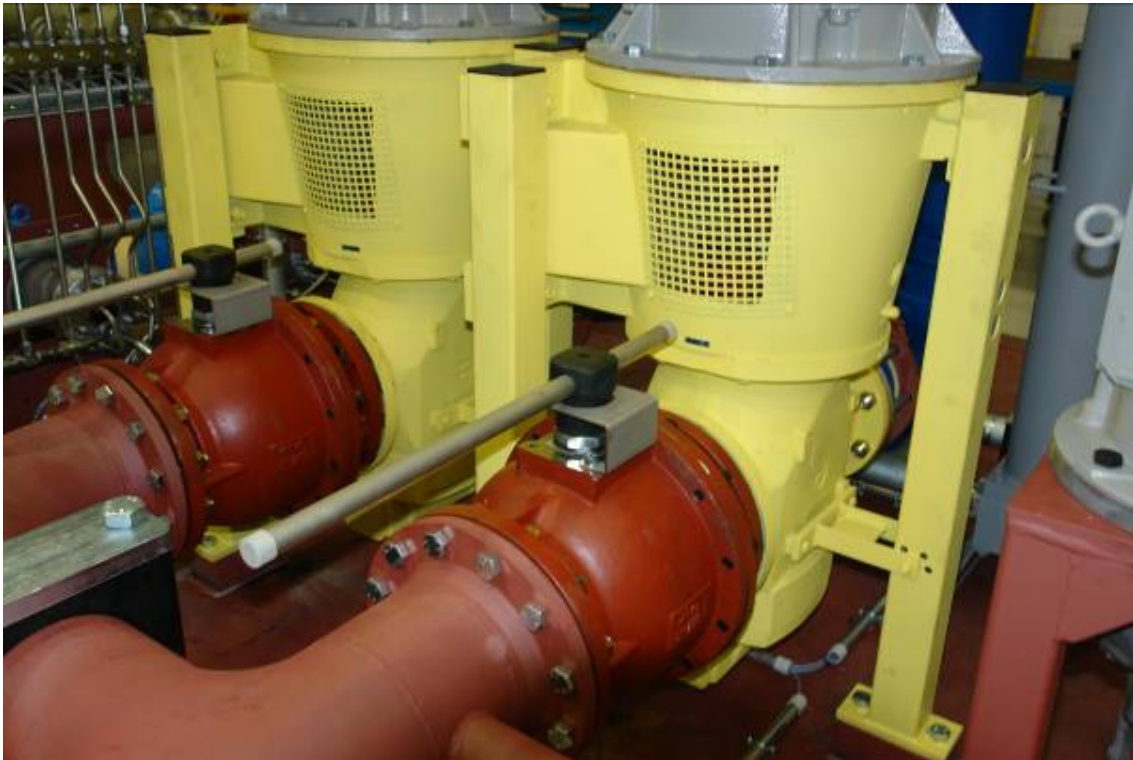
Dreispingelige Schraubenspindelpumpe der Baureihe TRF in einer Ölversorgungsanlage (Bauart „OWGM“) für einen Vertikalmühlenantrieb. Gefördert wird Synthetik- oder Mineralöl VG320 mit einem Druck von 10 bar.
