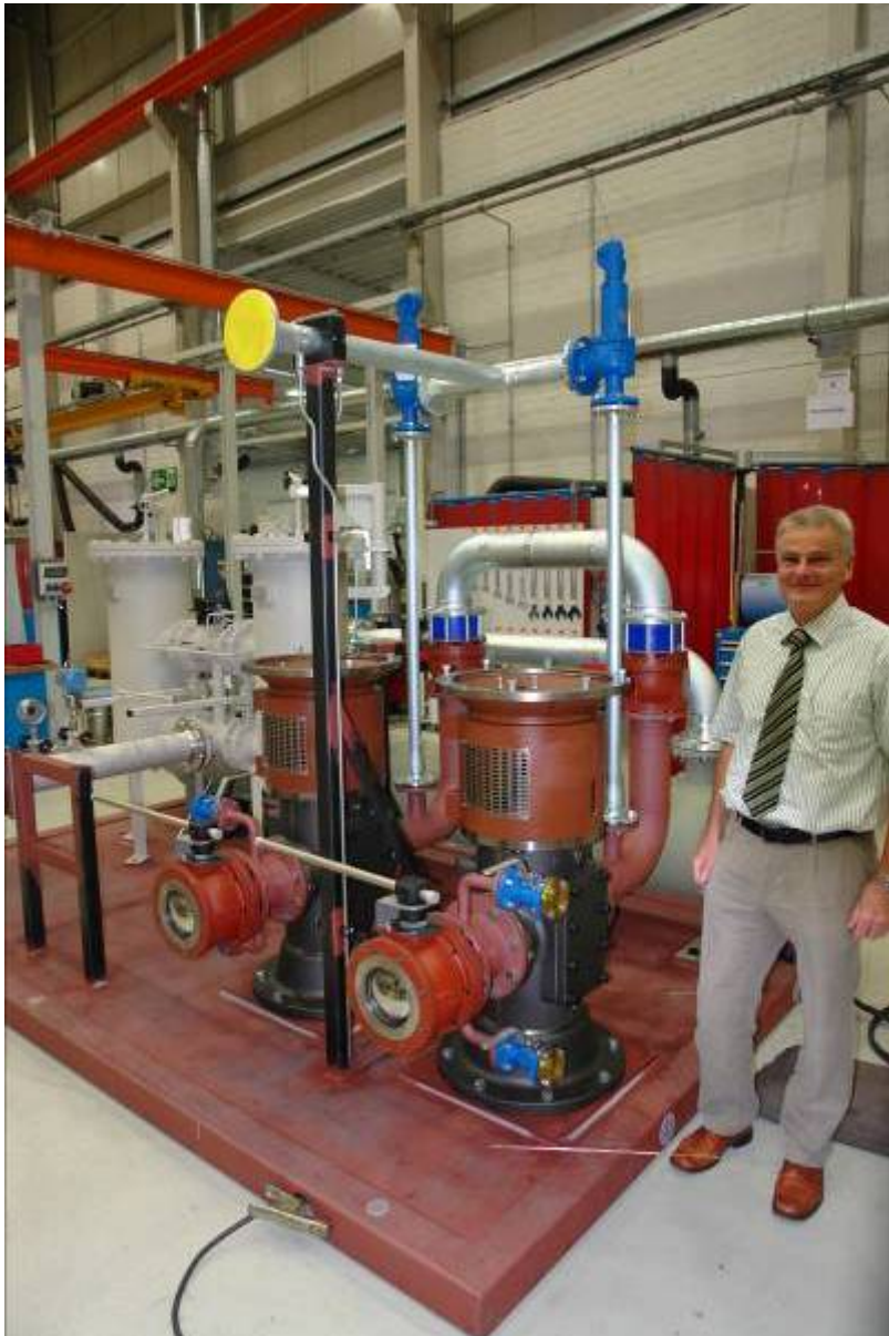
Dreispendelige Schraubenspindelpumpen der Baureihe SNS als redundantes Doppelaggregat in einer Ölversorgungsanlage (Bauart „OWGX“) für einen Extruderantrieb. Gefördert wird Synthetik- oder Mineralöl VG320 mit einem Druck von 8 bar.
