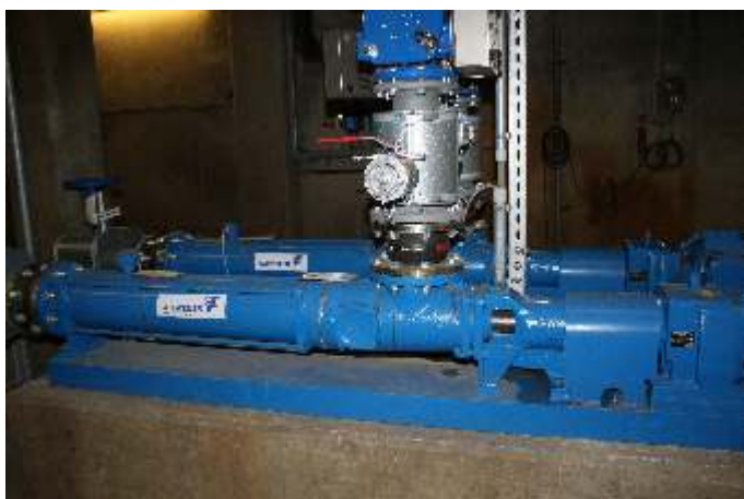
Etwa 80 % aller Pumpen der Anlage sind von Allweiler®. Das Bild zeigt die Dünnschlammumpen.
