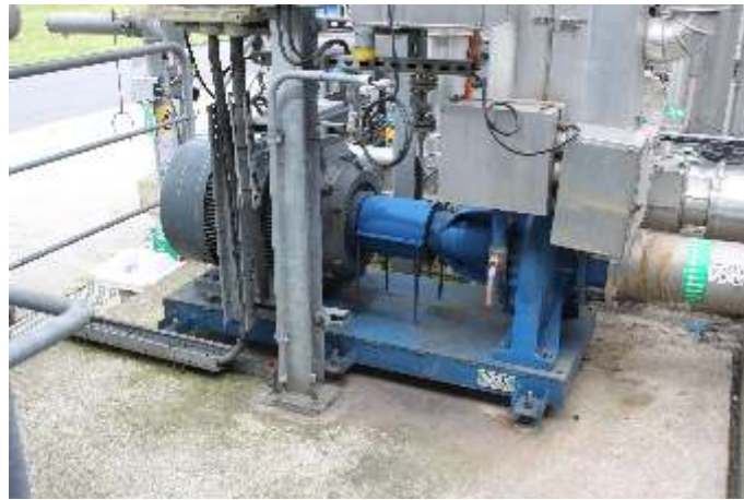
Baureihe NT150-400/02, Förderdaten 350 m 3 /h, 5 bar, Medium Kühlwasser, Prozess Kühlwassersystem
