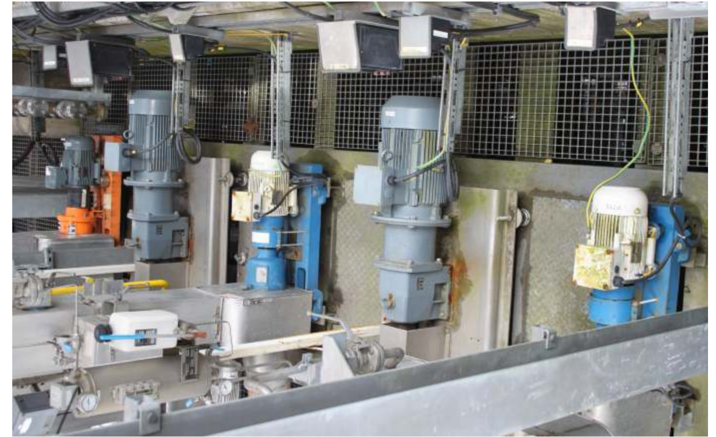
Baureihe CMAL 32-200/1, Förderdaten 15 m 3 /h, 1,2 bar, Medium Natronlauge (50%ig), Prozess LKW-Entladung Baureihe AK440-227-12, Förderdaten 30 m 3 /h, 1 bar, 30 °C, Medium wässriges Polycarboxylat, Prozess LKW-Entladung Baureihe CMAL 32-200/1, Förderdaten 15 m 3 /h, 0,9 bar, 40 °C, Medium Phosphorsäure (75%ig), Prozess LKW-Entladung Baureihe AK450-334-08, Förderdaten 40 m 3 /h, 2,5 bar, 80 °C, Medium Polyethylenglykol, Prozess LKW-Entladung
