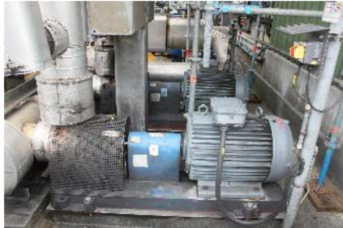
Baureihe ALLTHERM® Typ CHT 65-250, Förderdaten 75 m 3 /h, Medium Thermalöl, Prozess Beheizungssystem 250 °C.
