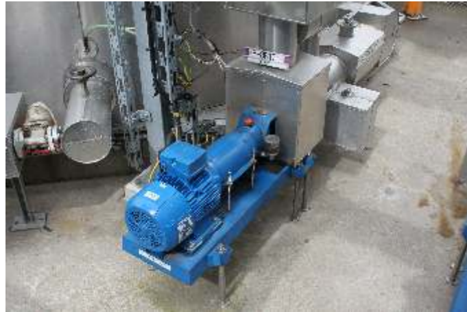
Baureihe CNH-B 40-160/11 G-W20, Förderdaten 20 m 3 /h, Medium Farmin DM20, Prozess Tanklager-Entladung.
