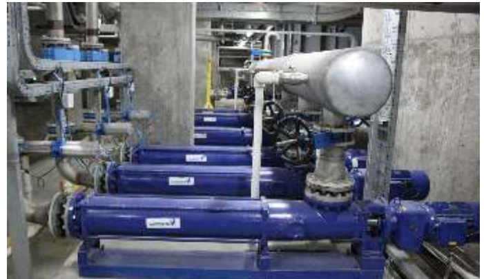
Anwendung: Schlammförderung Baureihe: ALL-OPTIFLOW® Fördermenge: 100-150 m³/h / 440-661 gpm Druck: 3-4 bar / 43,5-58 psi
