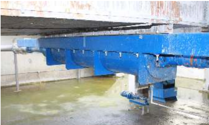
Anwendung: Die große Pumpe fördert 20-25%igen Schlamm von den Silos zu den Trocknern. Die kleine Pumpe dosiert Polymere, um den Reibungsverlust in der Rohrleitung zu minimieren.
