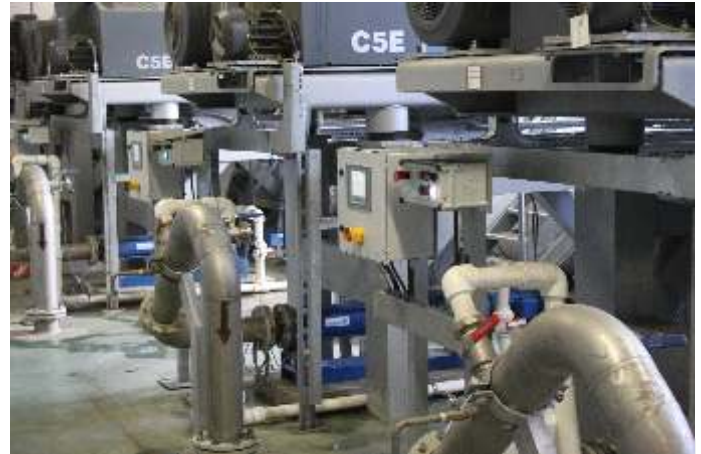
Anwendung: Schlammförderung zu Zentrifugen zur Entwässerung auf bis zu 20-25 % Baureihe: ALL-OPTIFLOW®
