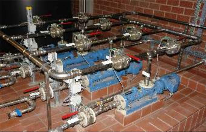
**Allweiler®-Exzenterschneckenpumpen der Baureihe AEB dosieren die Flockungshilfsmittel.**
