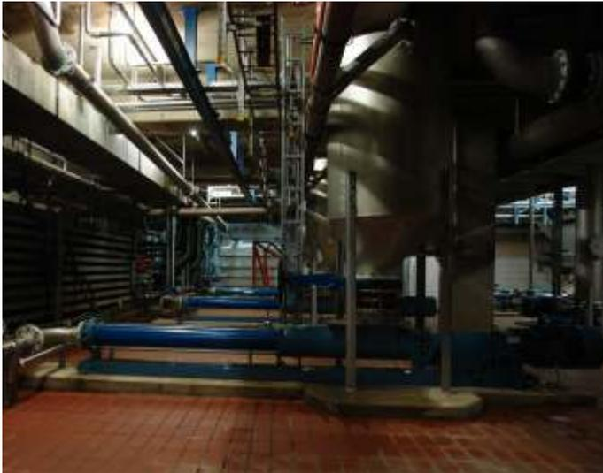
**Austragspumpen der Baureihe AE fördern 5-10 m³/h abrasiven Dickschlamm bei 8-12 bar Förderdruck.**
