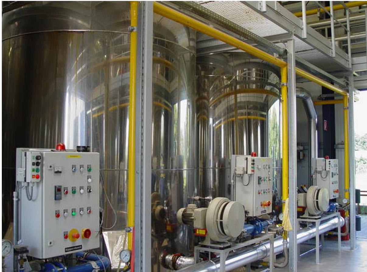
Die Pumpen sind auf Grundplatten in Reihe montiert. Deshalb müssen sie genau dosierbar sein und jeweils die gleiche Förderleistung erbringen.
