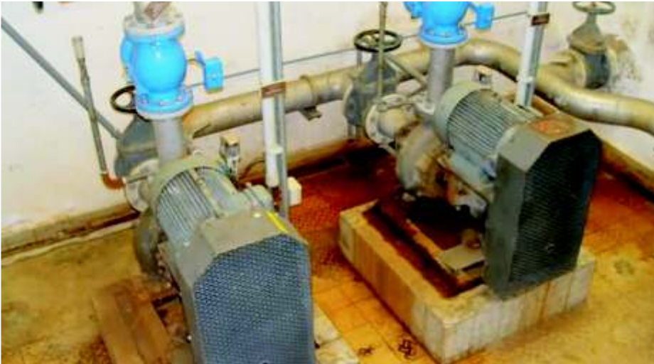
Durch die Optimierung entfallen diese beiden Kreiselpumpen und damit ihre Strom- und Wartungskosten.
