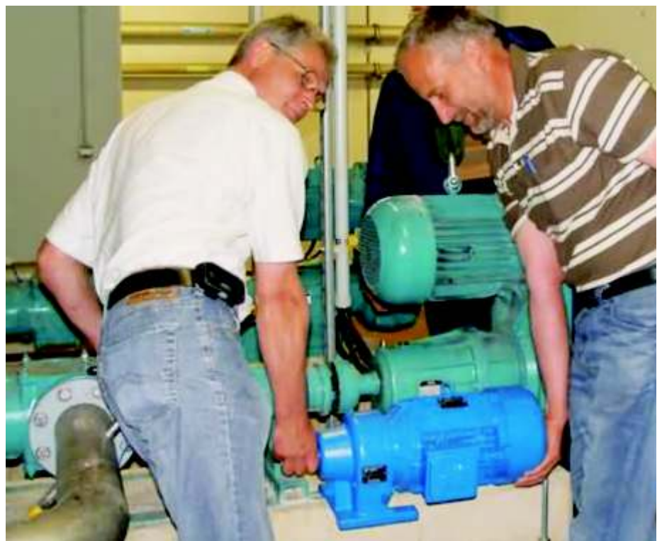
Zum Vergleich: neuer, deutlich kleinerer EFF1-Motor vor dem alten Motor mit Riemengetriebe.
