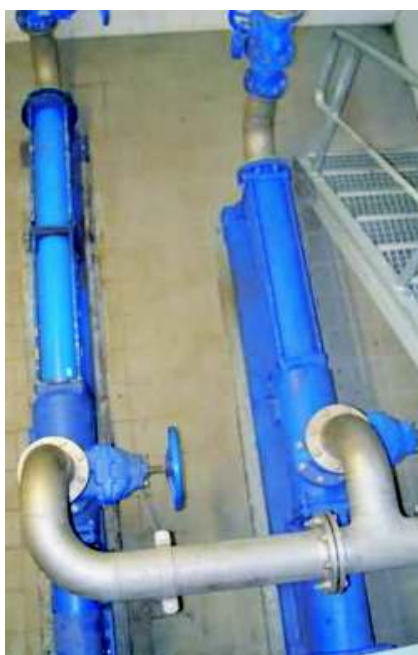
Die Vorfüll-Pumpe AE..N zur Beschickung der Kammerfilterpresse (rechts) wird umgebaut, so dass sie identisch mit der bereits vorhandenen AE..H (links) ist.
