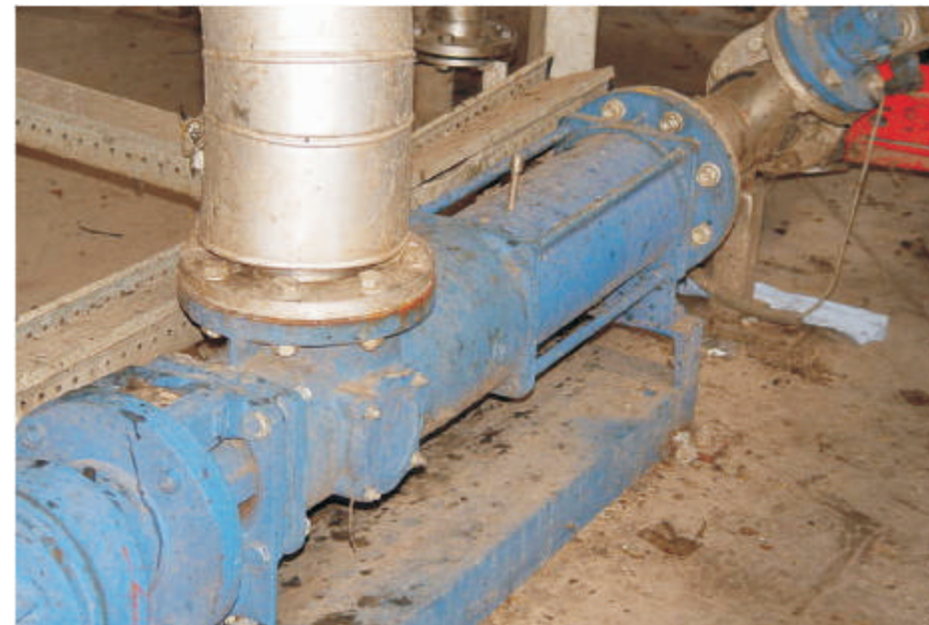
ALLWEILER Exzentrerschneckenpumpe der Baureihe AEB1E750, Medium: Biomasse mit 75 °C, Fördermenge 18 m 3 /h, Druck 2 bis 4 bar.
